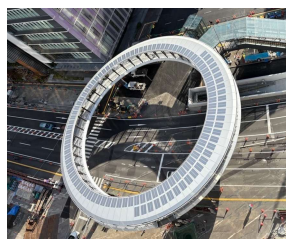
円形デッキに太陽光発電、蓄電池を整備
