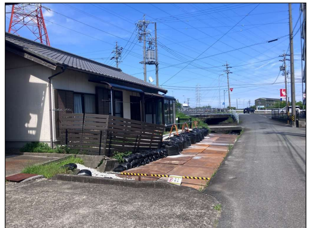
応急復旧状況（仮配管埋設）
