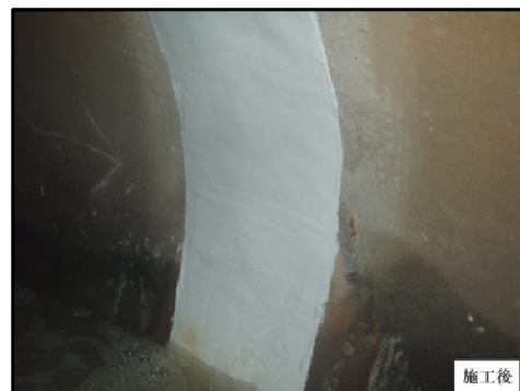
防食被覆 施工後
