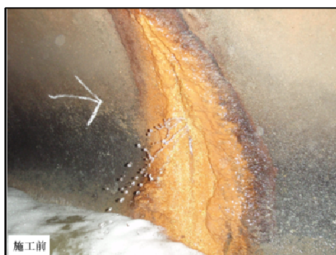
防食被覆 施工前
