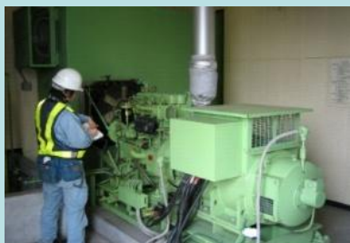
【排水ポンプの整備】
