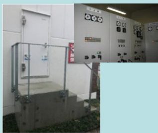
【地下電源への 防水扉設置や高上げ】
