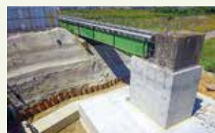
水道施設（水管橋）の耐震補強
