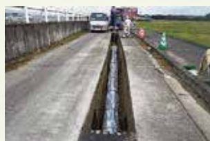
ダクタイル鋳鉄管の 布設替え工事
