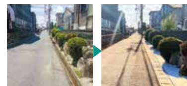
側溝の整備 整備前(左)→整備後(右)
