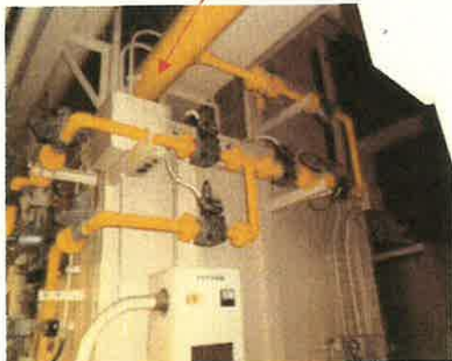
既存火葬炉の既存燃料配管の位置
