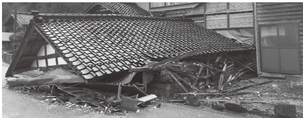
能登半島地震で被害を受けた木造住宅
