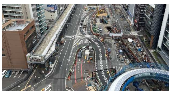
バスタ周辺の工事状況
