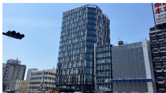
新たに竣工したオフィスビルと隣ではマンションが建設中
