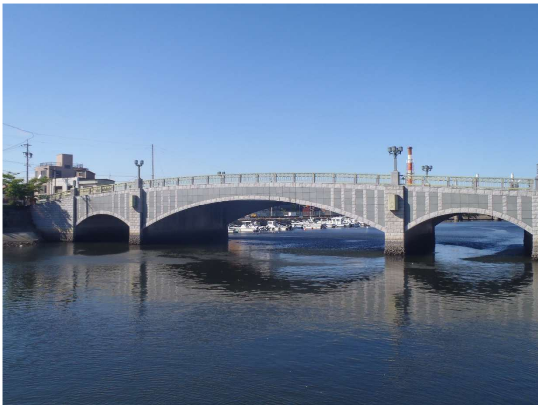
あいおい 相生橋（諏訪新道線、平成7年竣工）
