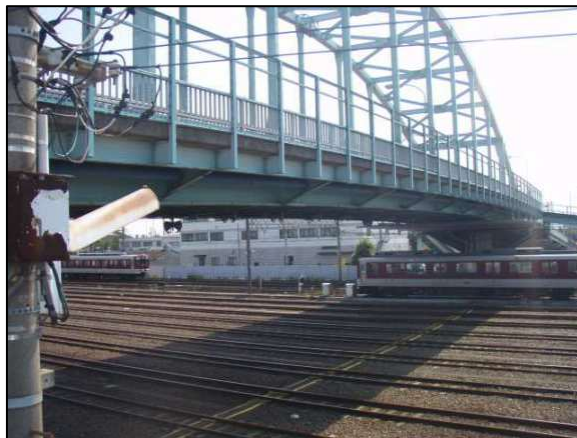
馳出跨線橋 (近鉄線・JR貨物線を跨ぐ橋梁)
