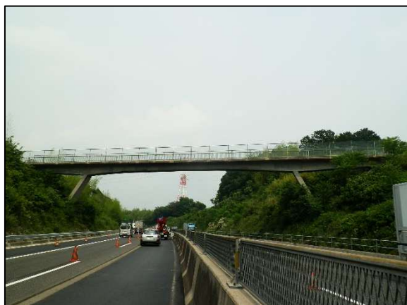
横谷橋 (東名阪自動車道を跨ぐ橋梁)
