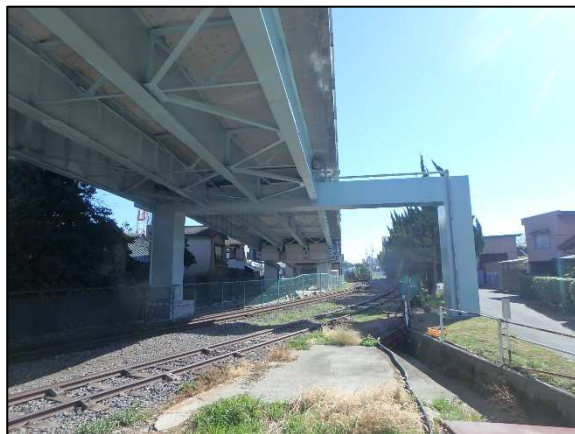
塩浜跨線橋 (近鉄線・JR貨物線を跨ぐ橋梁)
