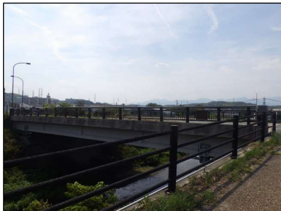
つんつく大橋 (緊急輸送道路に架かる橋梁)
