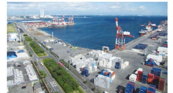
霞ヶ浦地区コンテナターミナルの様子
