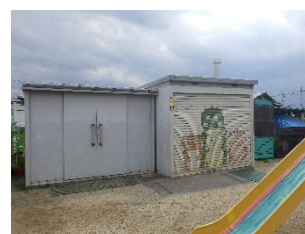
図 3.15 後設置の屋外倉庫
