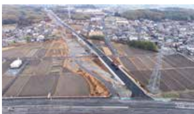
開通区間の終点・国道477号バイパス (令和7年1月撮影)
