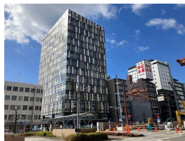
※三重県初CASBEE-スマートウェルネスオフィス認証最高位Sランク取得 経済産業省ZEB（ネット・ゼロ・エネルギー・ビル）実証事業採択
