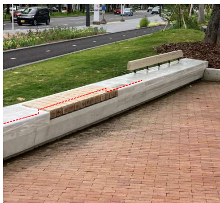
座面部の段差設置イメージ
