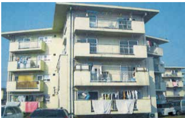
学生が入居している市営住宅の外観
