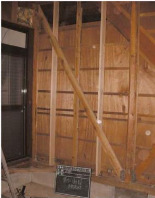
[筋かいによる壁の補強状況]
