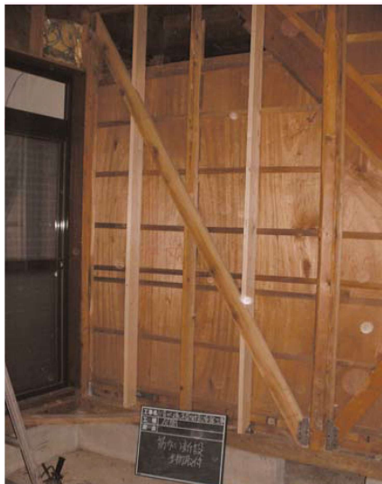
[筋かいによる壁の補強状況]
