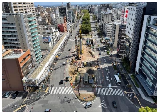
中央通りの工事状況【円形デッキ付近】
