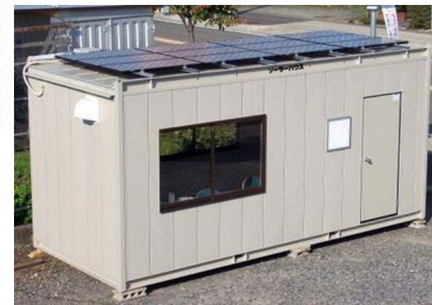
③太陽光発電を備えた仮設ソーラーハウスの設置
