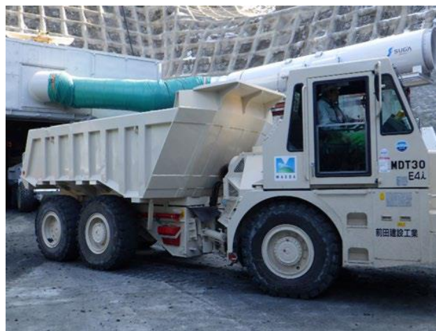
①GTL fuelを採用したオフロードダンプ(掘削ずり運搬)
