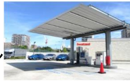
水素ステーションの設置
