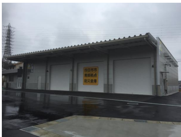
南部拠点防災備蓄倉庫
