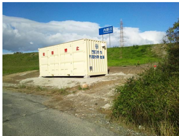
水防倉庫（内堀:内部川）
