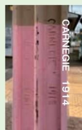
支柱として再利用された古いレールに残る CARNegie 1914 の刻印。鉄鋼業で成功したアメリカのカーネギー社製だとわかります
