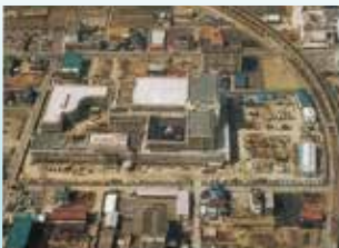
開館時の文化会館と周辺(昭和57年)
