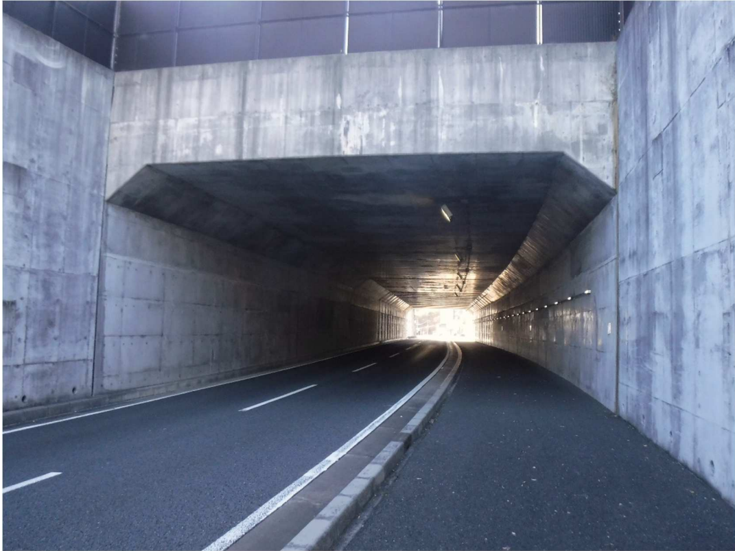
たるさか 垂坂環状1号線大型カルバート (たるさか 垂坂環状1号線)
