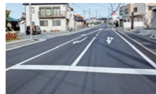
◀三重橋垂坂線再舗装
