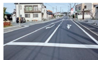
◀三重橋垂坂線再舗装
