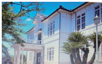
これから改修工事に入る「四郷郷土資料館」です。素敵だと思わずパチりました(さくなつちいさん)
