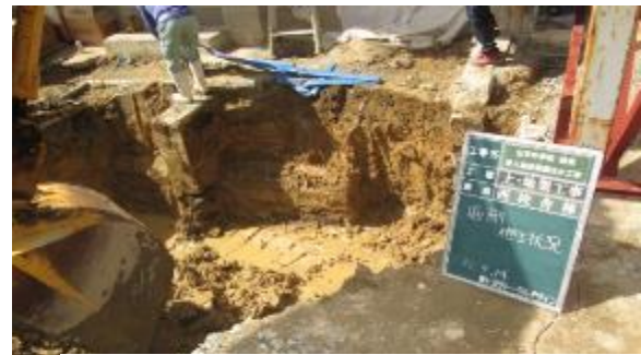
2. 基礎を作るための掘削
