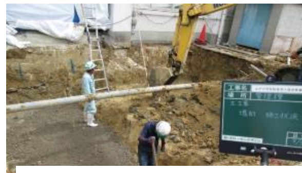
2. 渡り廊下撤去後に、基礎掘削
