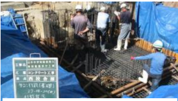
3. 砕石締固め後、配筋施工、生コンの打設
