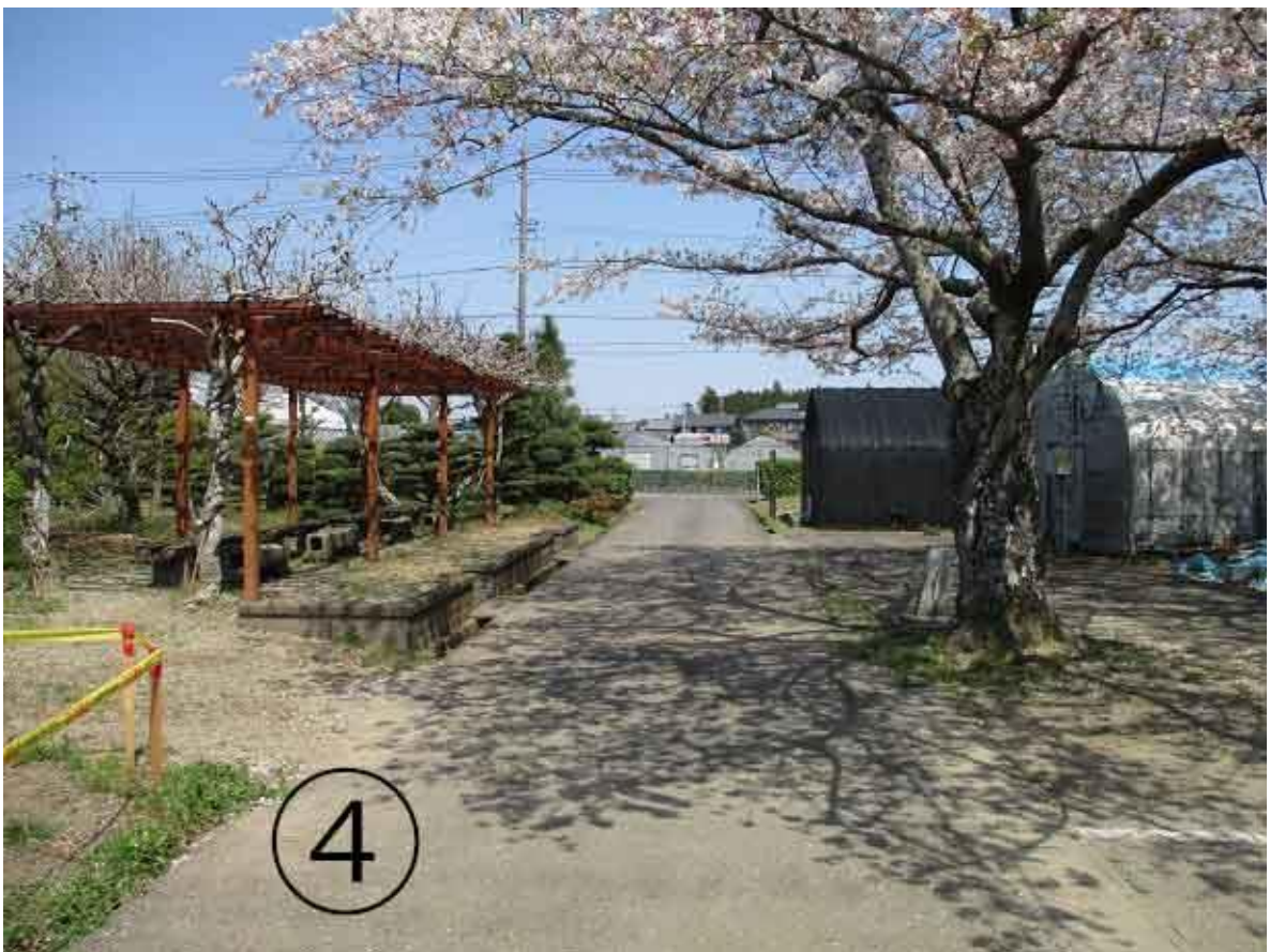
工事着手前の状況。赤道から北を撮影。
