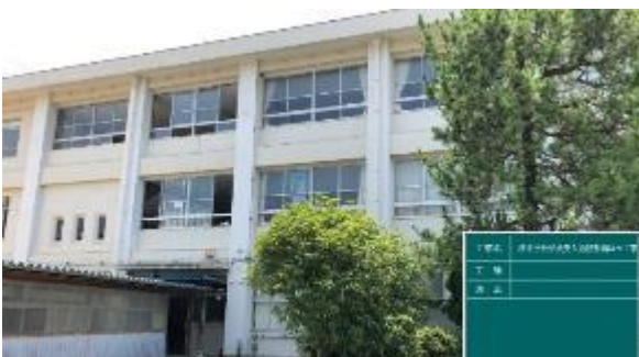
1. 着工前、渡り廊下撤去前
