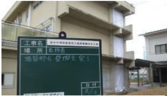
1. 工事着工前、増築部の壁撤去
