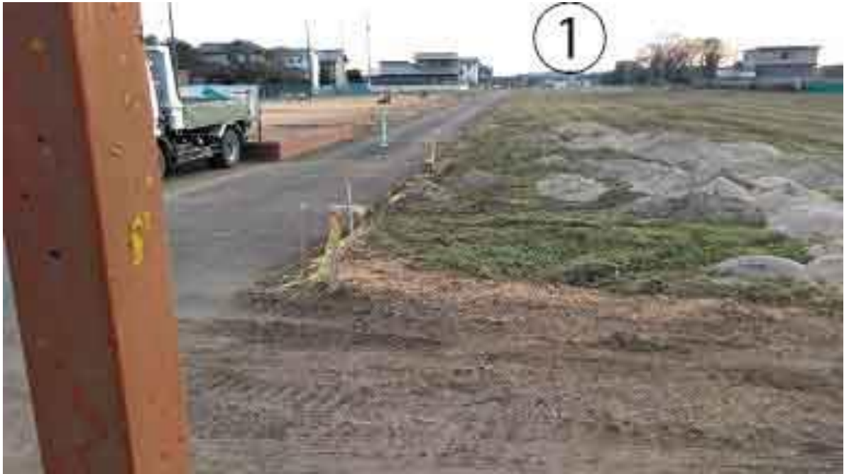
エアドーム 荷下ろし前の状況
