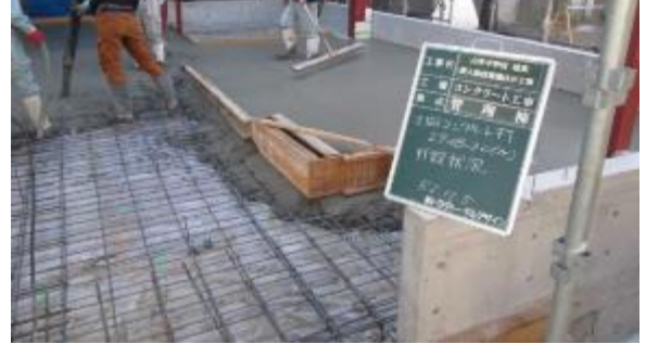
4. 相談室の床コンクリート
