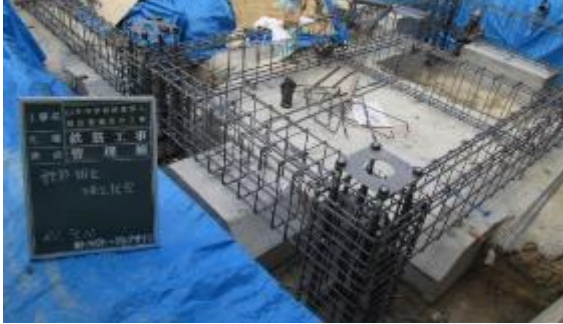
3. 基礎の配筋及び生コン打
