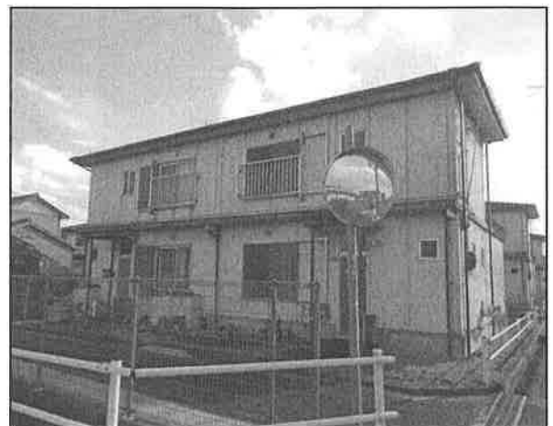
天白町市営住宅
