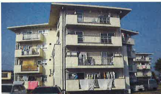
学生が入居予定の市営住宅の外観
