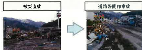
●道路啓開状況(出典:東北地方整備局道路部 東日本大震災対応記録誌)
