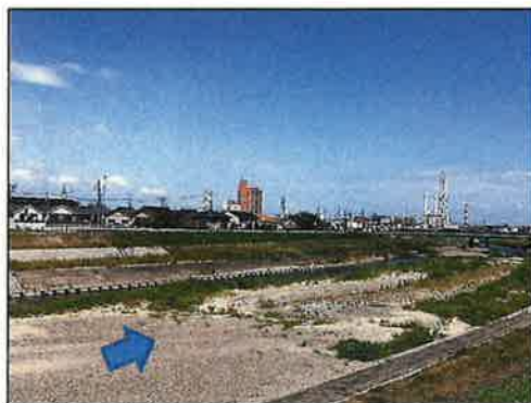
市街地を流れる三滝川。堤防の背後地に家屋が密集しています。
