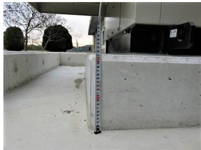
写真 14 自家発電装置据付基礎
