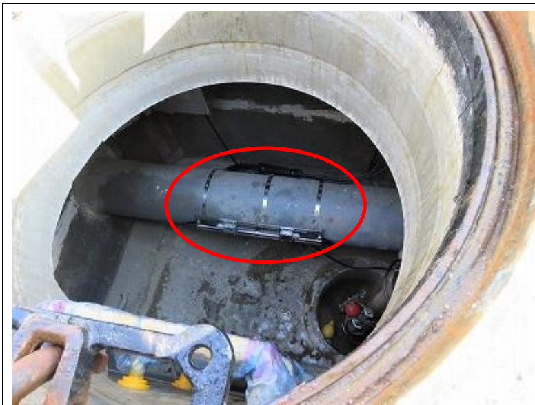
写真 7 超音波式流量計
