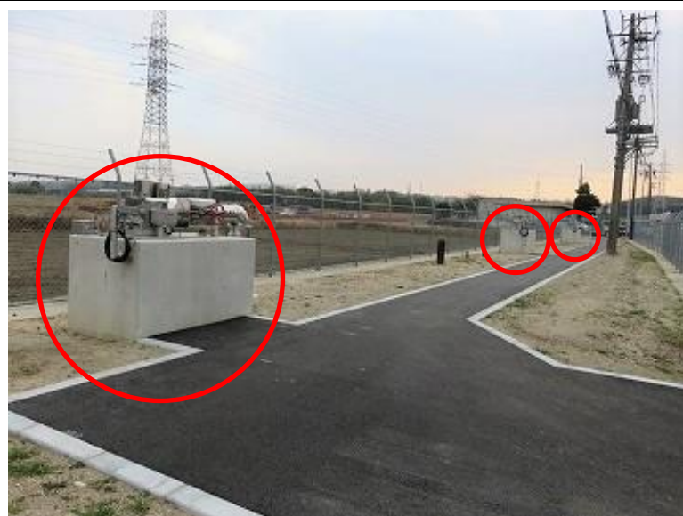
写真2 取水井戸 左手前から No. 1 取水井戸、No. 2 取水井戸及び No. 3 取水井戸
