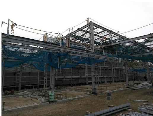
No.7 鉄骨工事施工状況①
