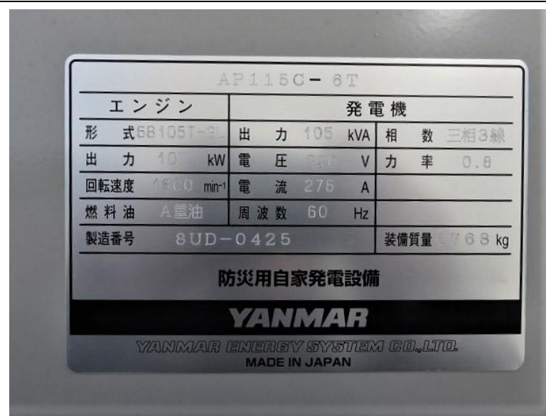
写真 13 自家発電装置銘版
