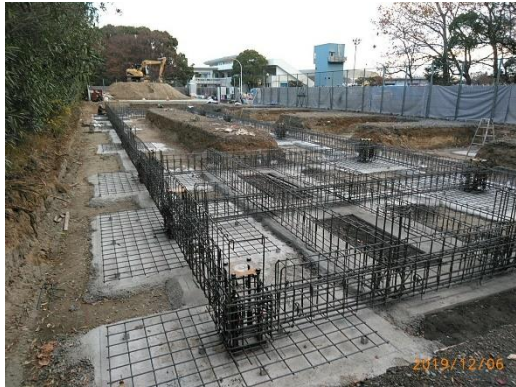
No.3 鉄筋工事施工状況
