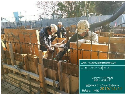
No.5 コンクリート工事施工状況
