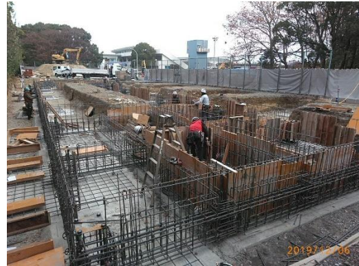
No.4 型枠工事施工状況
