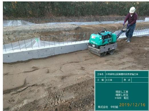
No.6 土工事施工状況
