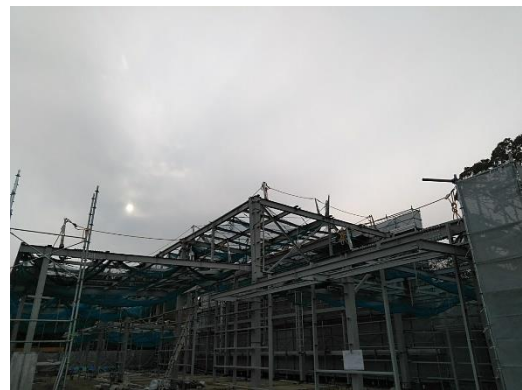
No.8 鉄骨工事施工状況②
