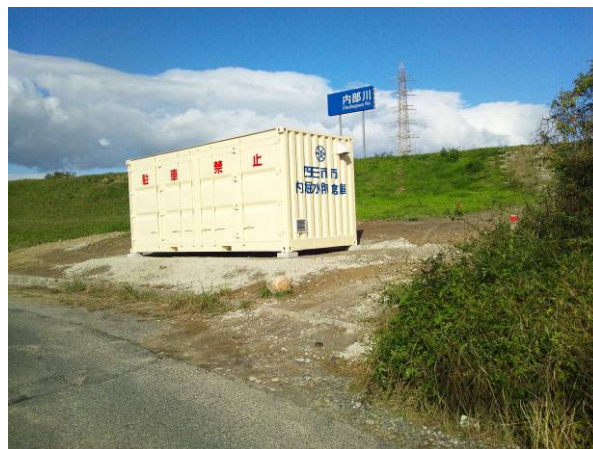
水防倉庫 (内堀:内部川)
