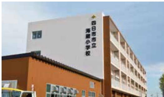
改修した海蔵小学校
