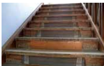
▲リノリウムが施された階段
