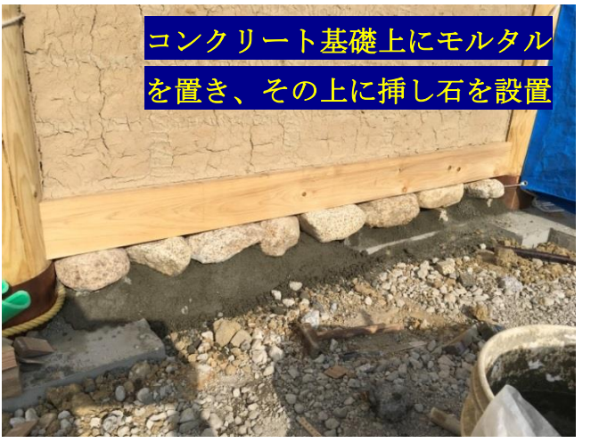
土塗り壁の小舞下地に荒壁の状況、以後、中塗り、2カ月乾燥後に仕上げ塗り
