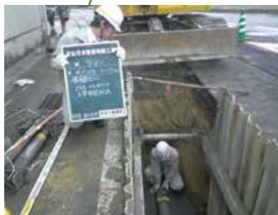
下水管の延伸工事
