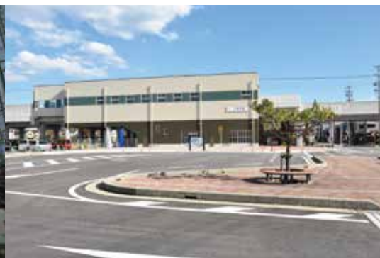
近鉄川原町駅前広場 (拠点駅周辺整備事業【連続立体交差事業】)
