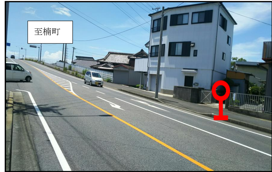
現場写真② (川合町)
