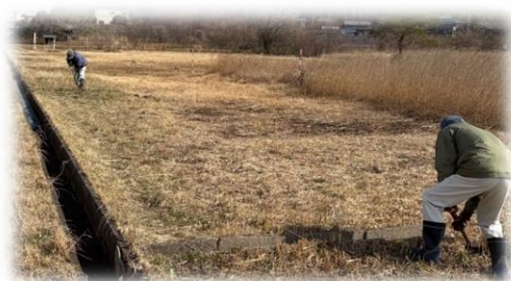
3/4 東部指定地 水路の浚渫
