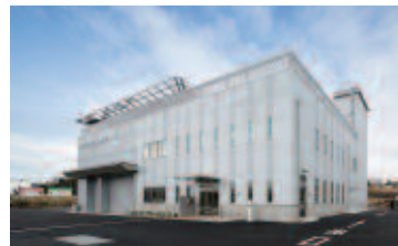
北消防署北部分署
