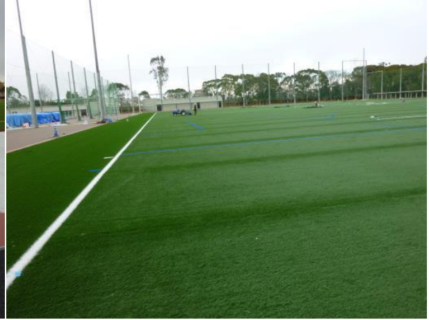
人工芝設置状況、線引き作業状況
