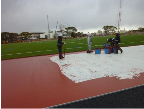
ウレタン舗装施工状況
