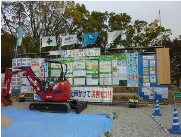
工事看板掲示状況
