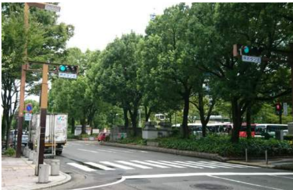
中央の緑地帯に押しボタン式信号が設置されて歩行者の横断をしやすくした例 (名古屋市の久屋大通)
