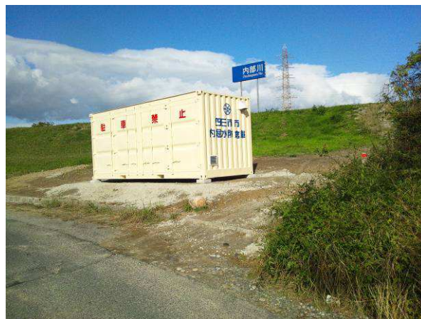
水防倉庫(内堀:内部川)
