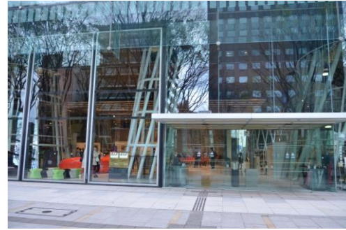
(1) 外部空間と一体的に活用できる設備の事例 (せんだいメディアテーク)
