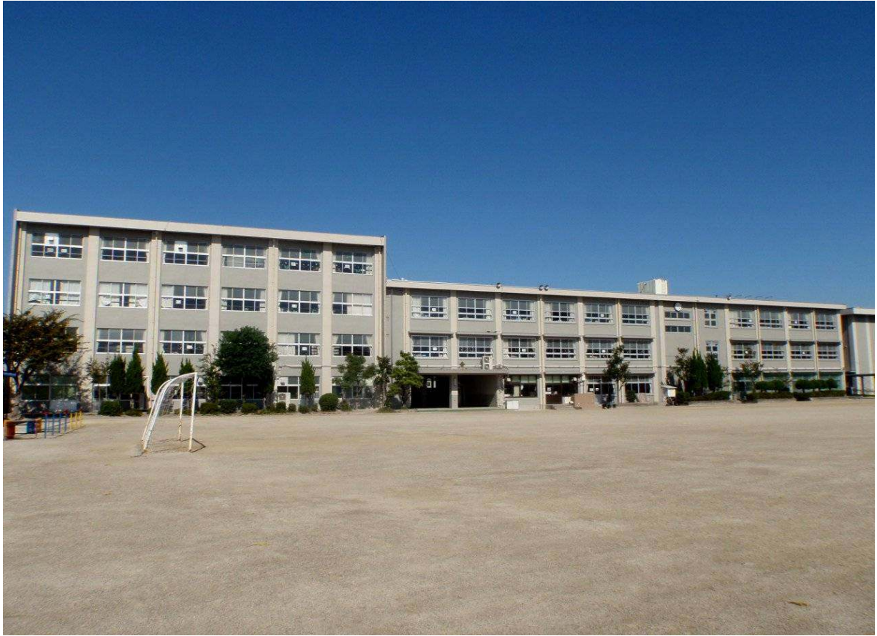
南側外観(外壁改修)
