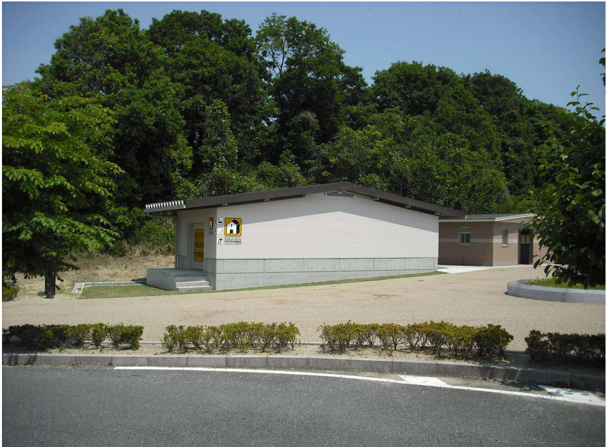
外観(右の建物は既設トイレ)
