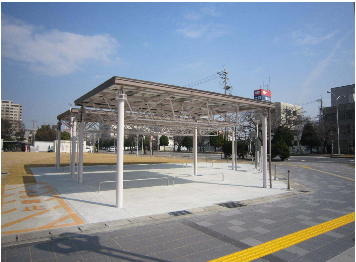
外観(南方向より)
