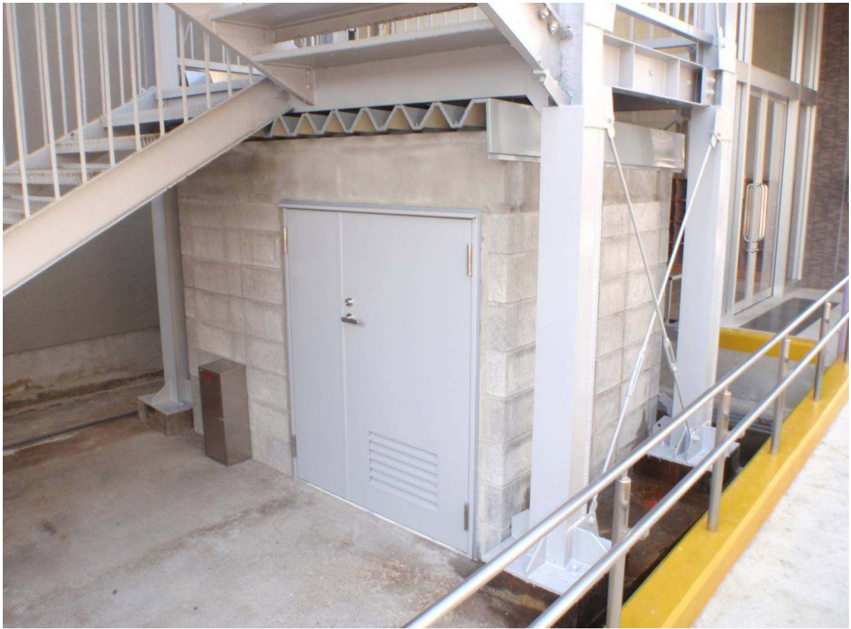
危険物倉庫増築
