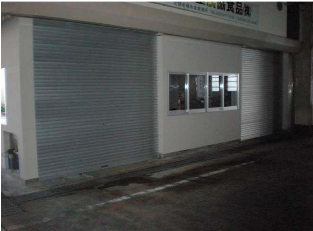
水産中卸売場改修
