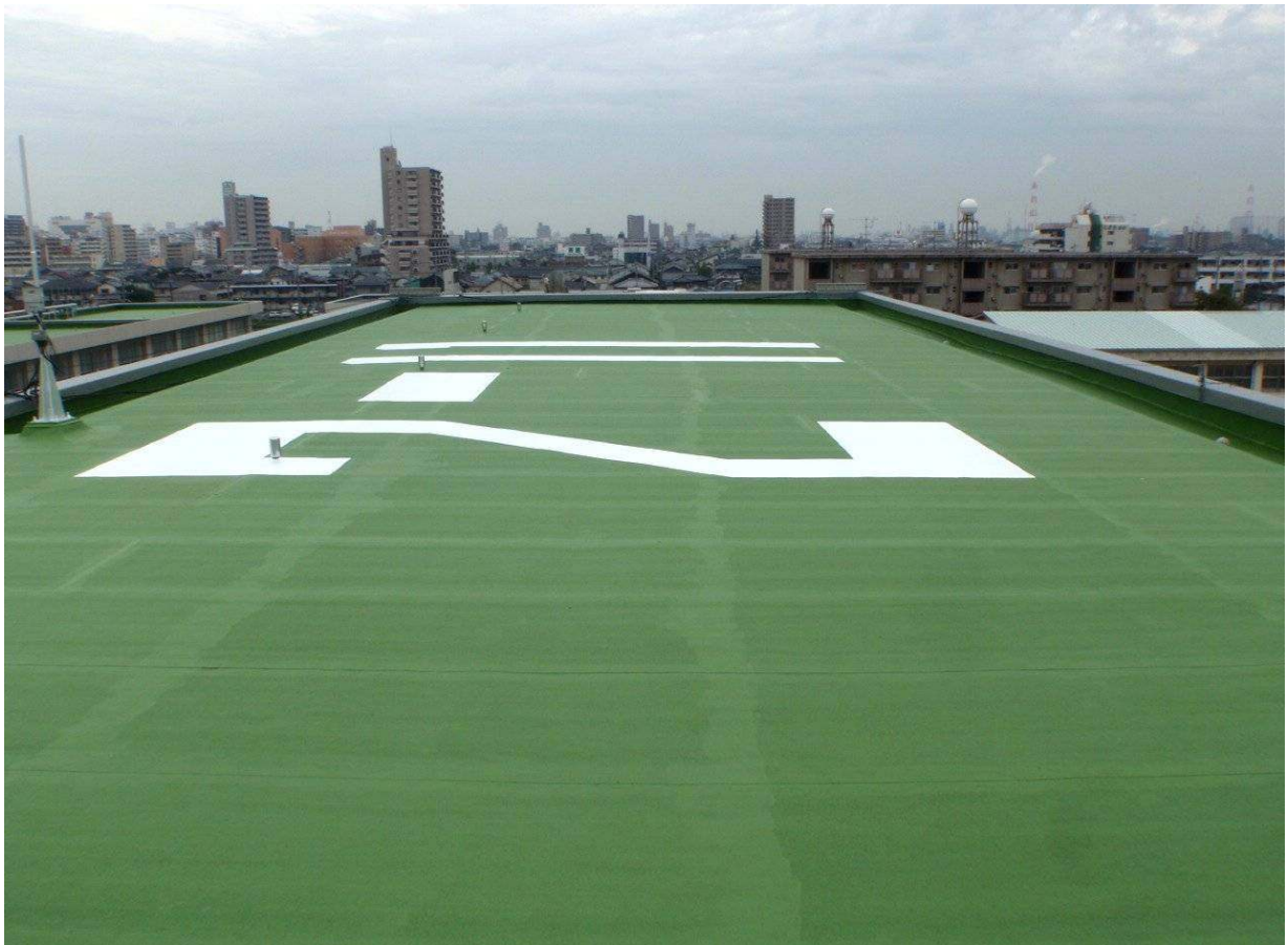
屋上防水改修
