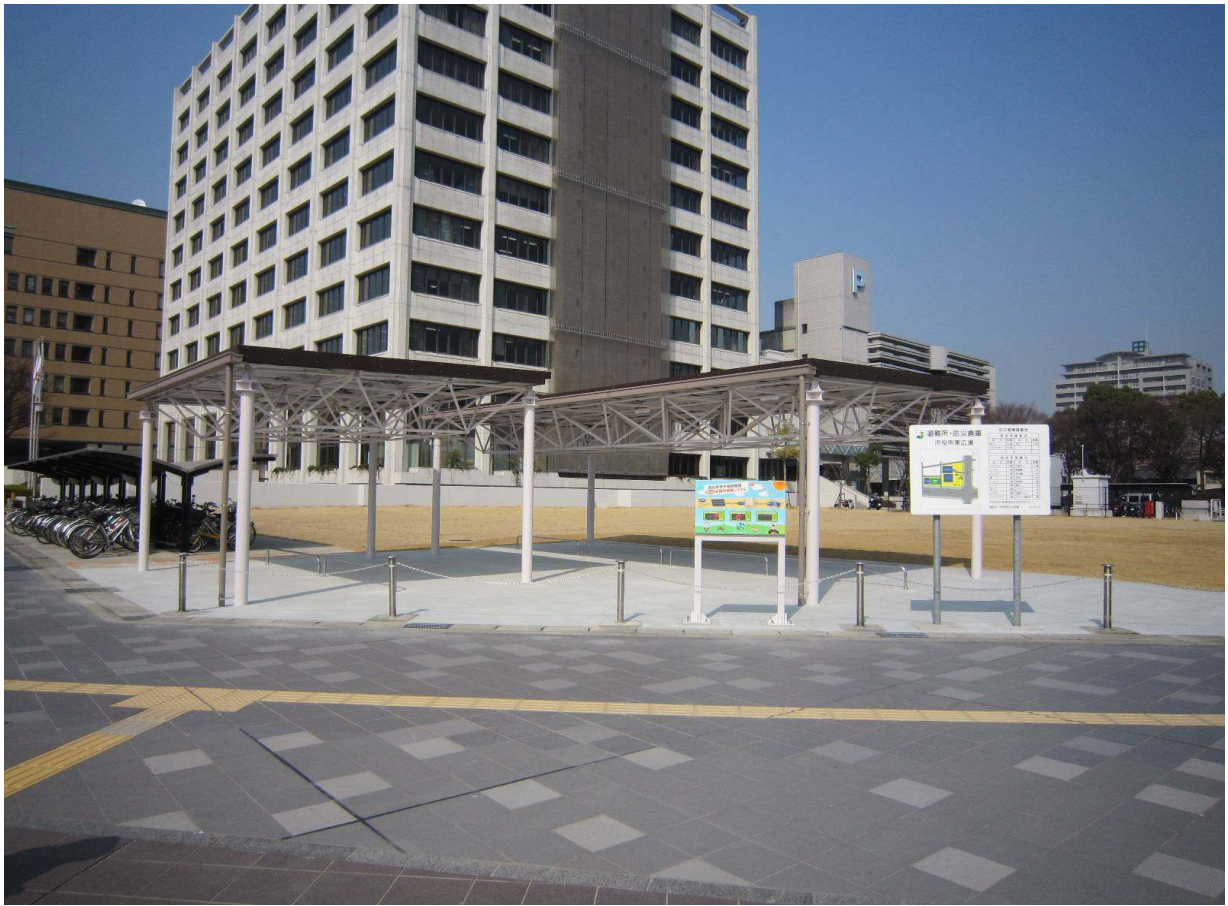
外観(南東方向より)
