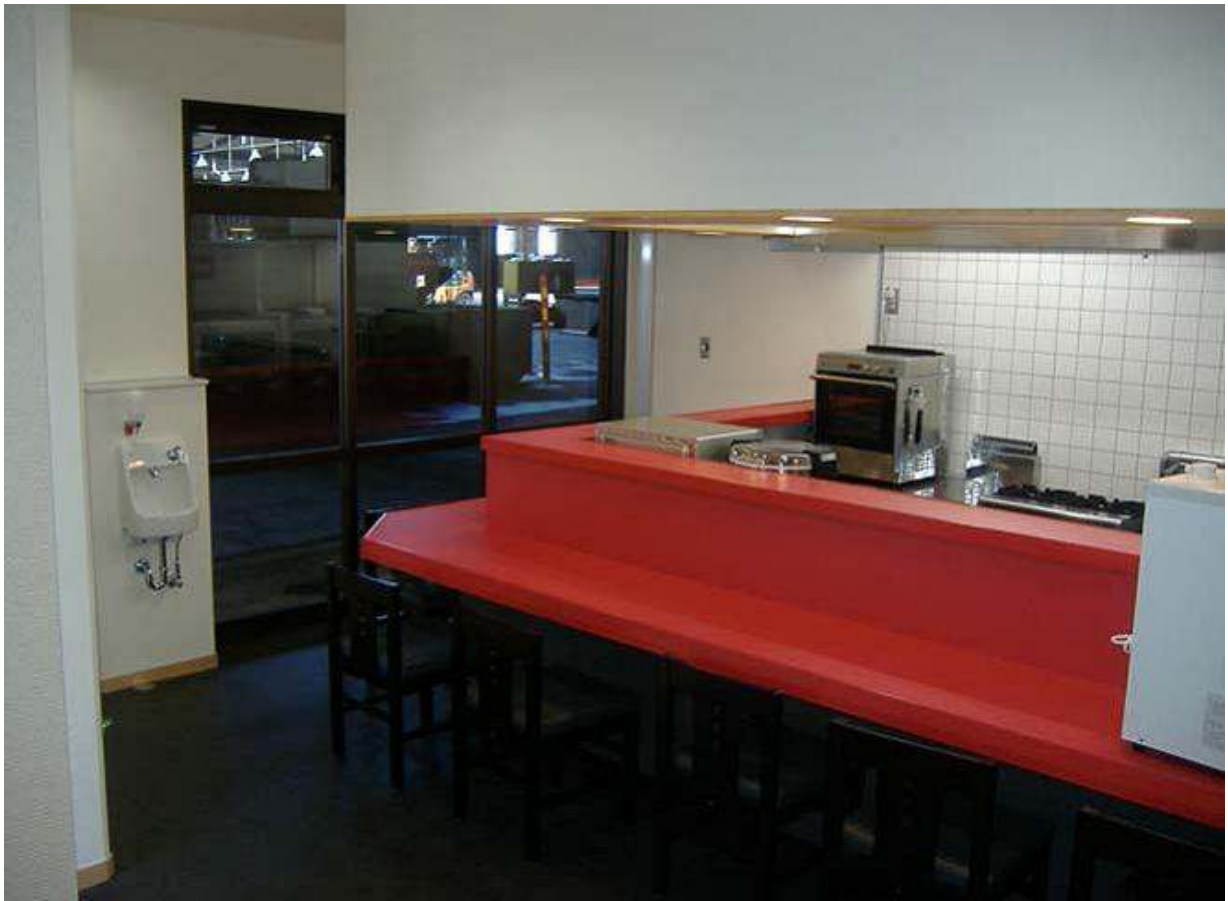
場内飲食店舗改修
