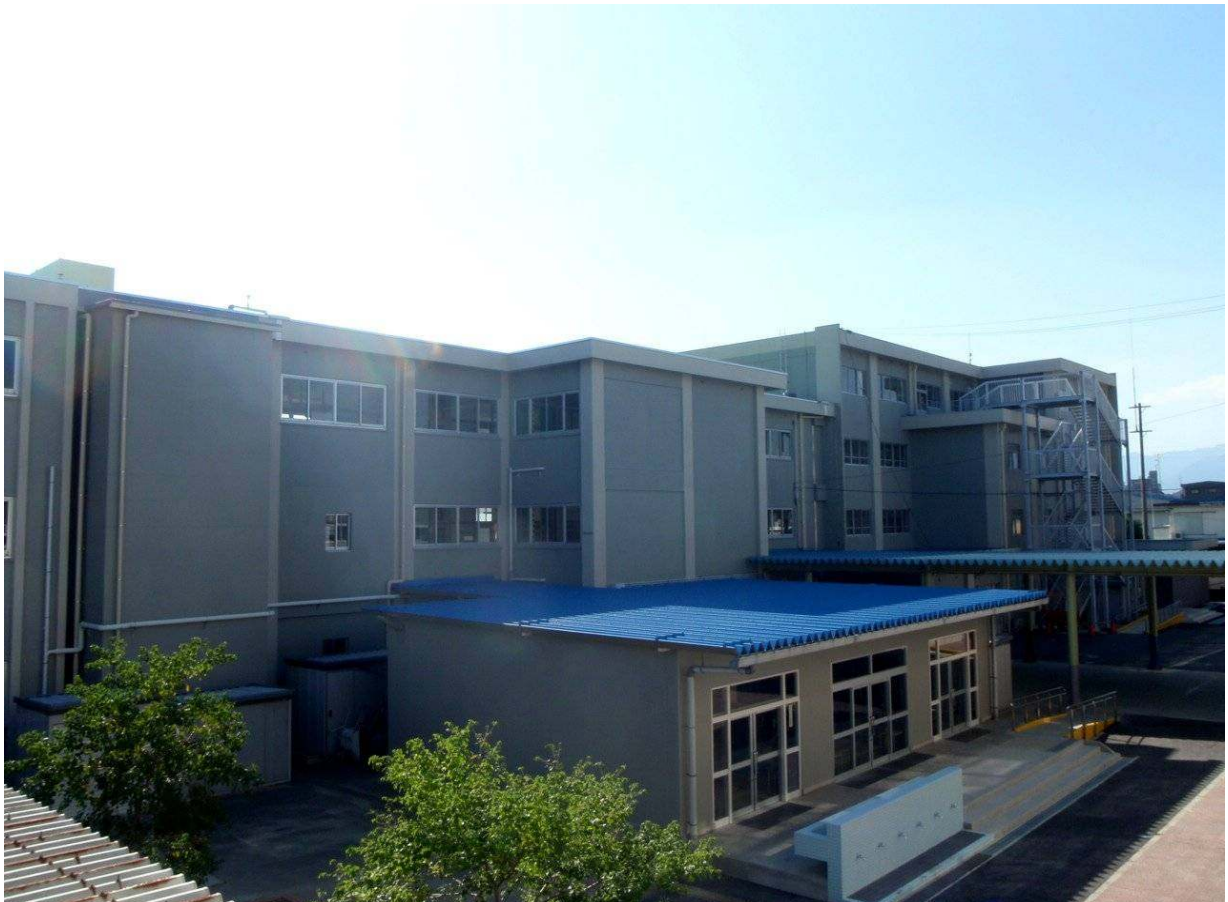
北側外観(昇降口改修ほか)
