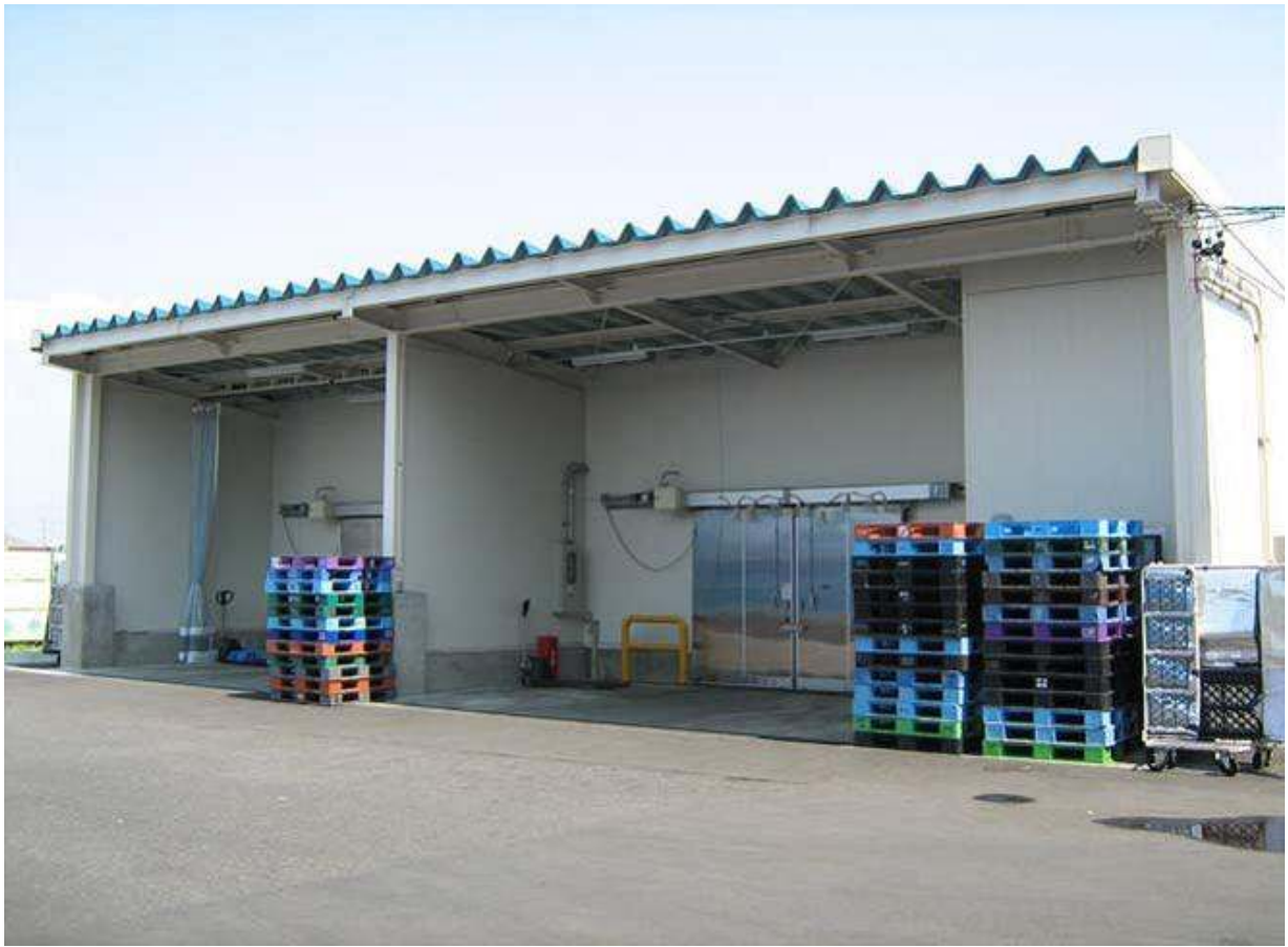
水産中卸低温荷捌所 外観
