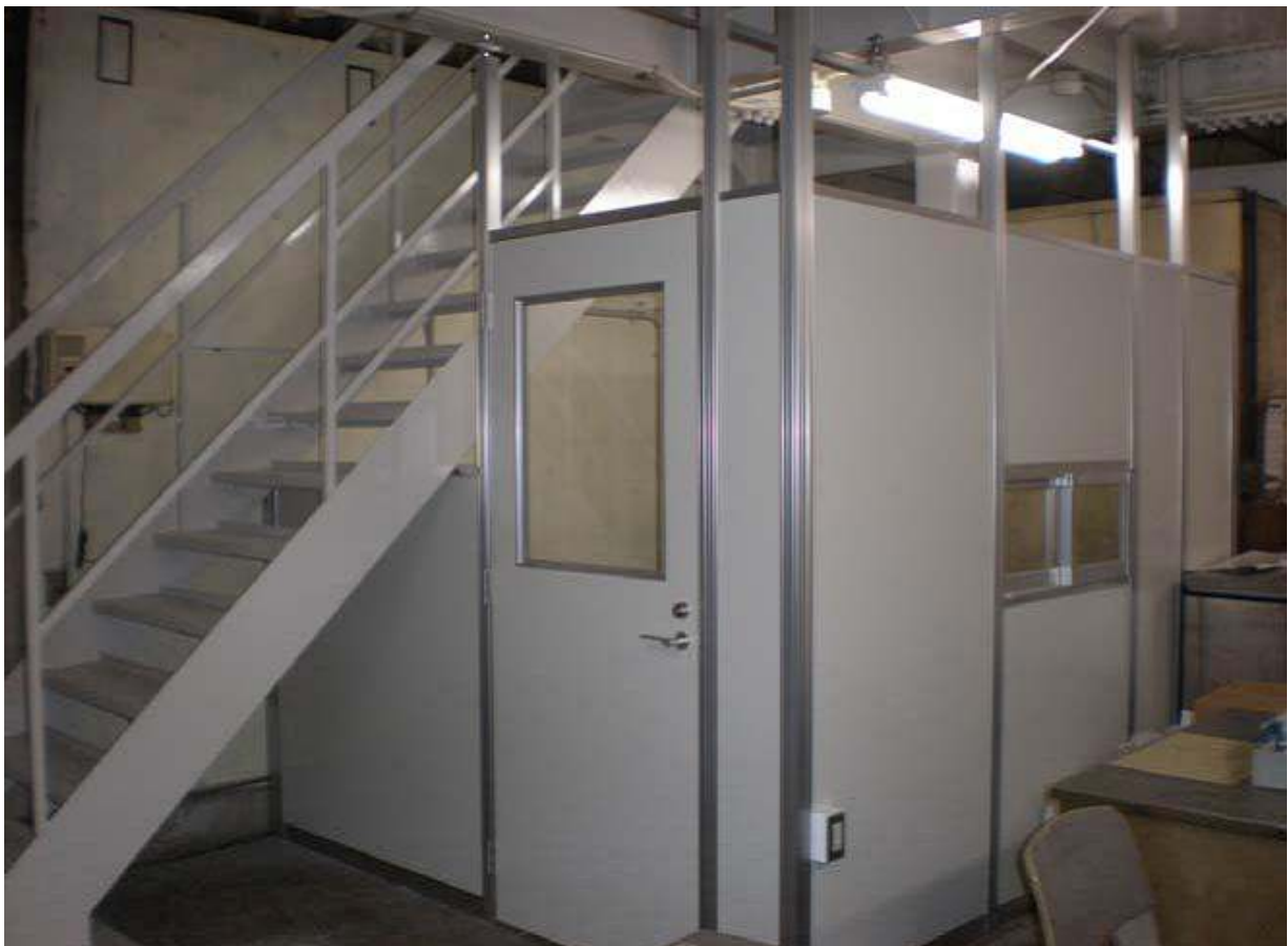
水産中卸売場改修
