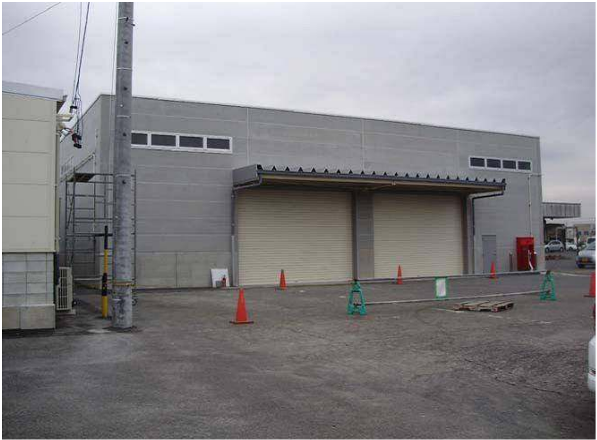
青果卸流通用コンテナ倉庫
