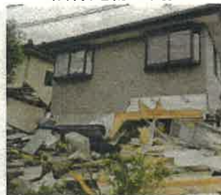
<隣棟建物の衝突>
