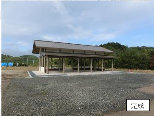
正殿建設工事
