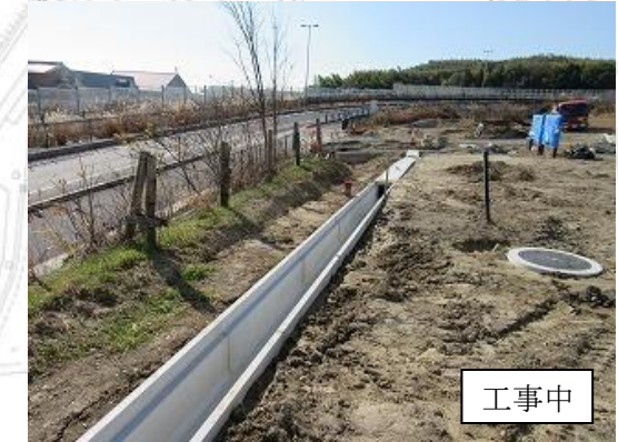
雨水排水溝設置
