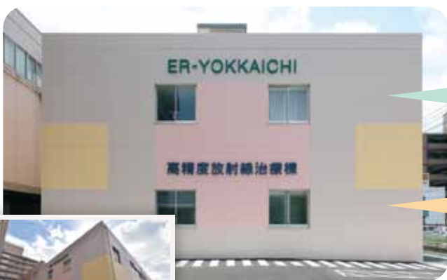
救急棟西側に増築、整備された高精度放射線治療棟
