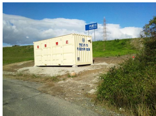
水防倉庫（内堀:内部川）
