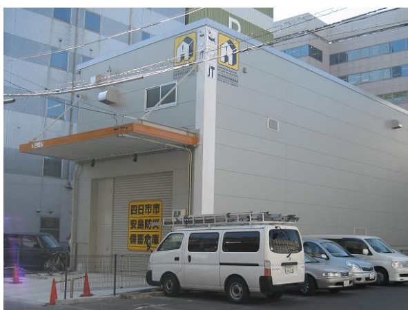
防災備蓄倉庫（安島）
