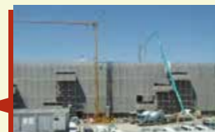
笹川中学校 (改装中)
