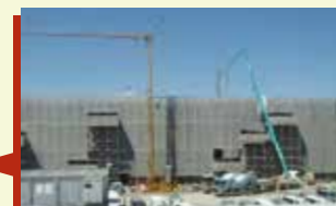
笹川中学校 (改装中)
