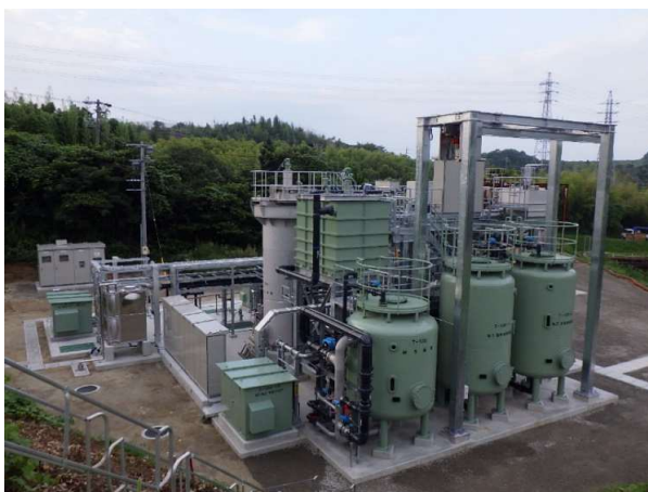
浸出水処理施設
