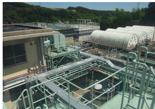
浸出水処理施設
