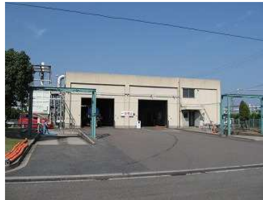
大井の川中継貯留槽
