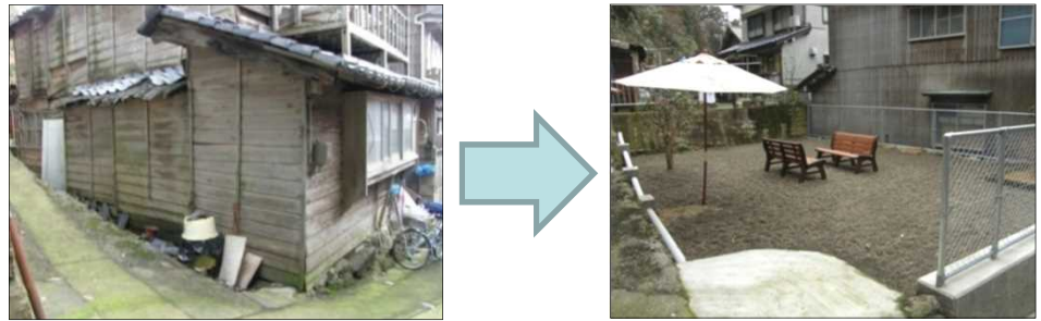
【福井県越前町】 老朽化した空き家住宅を除却し、ポケットパークとして活用
